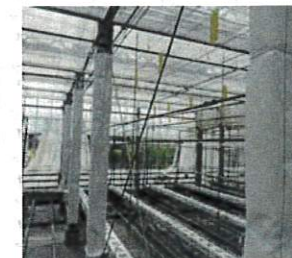
鉄骨の遮熱として使用
